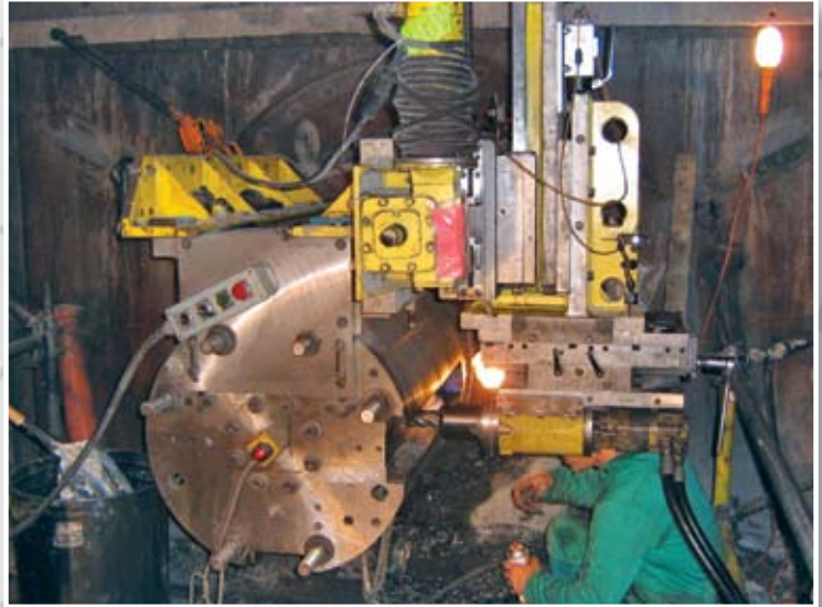
Restore BOF Shaft & Keyway
